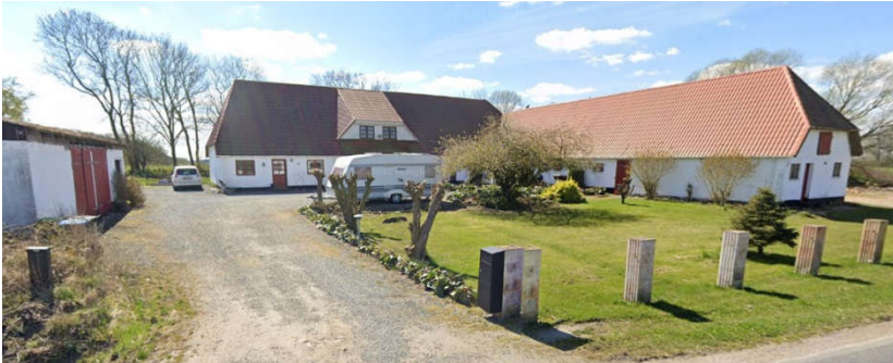
Visbjergvej 18 (Google Foto)
