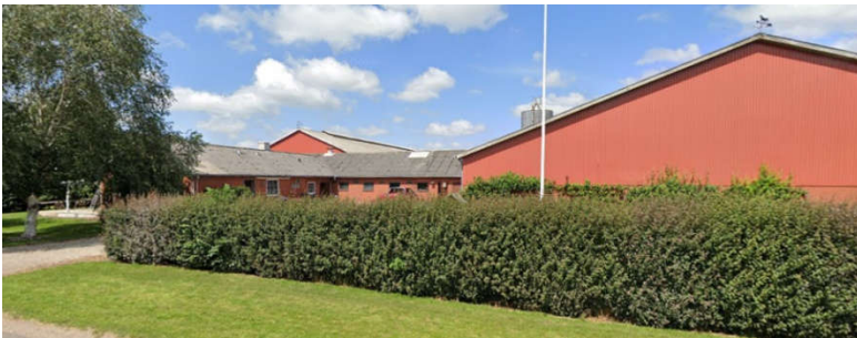
Ginegårdsvej 1 (Google Foto)
