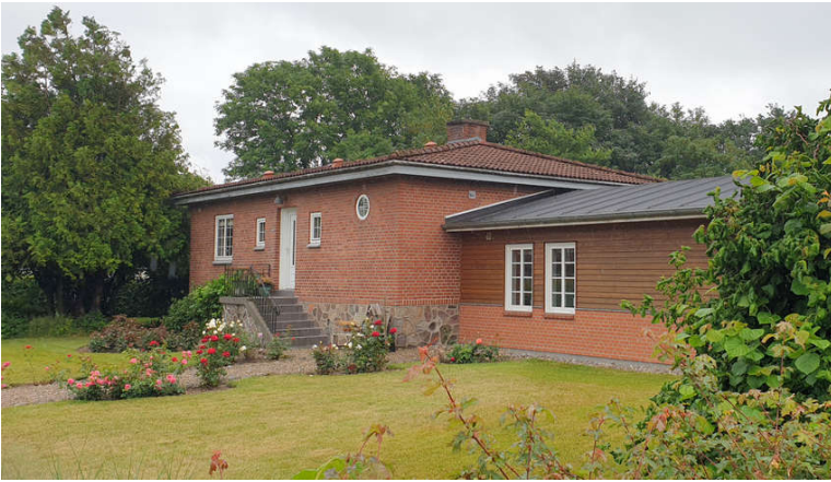
Lundbyesvej 16 (Foto: Juli 2021)
