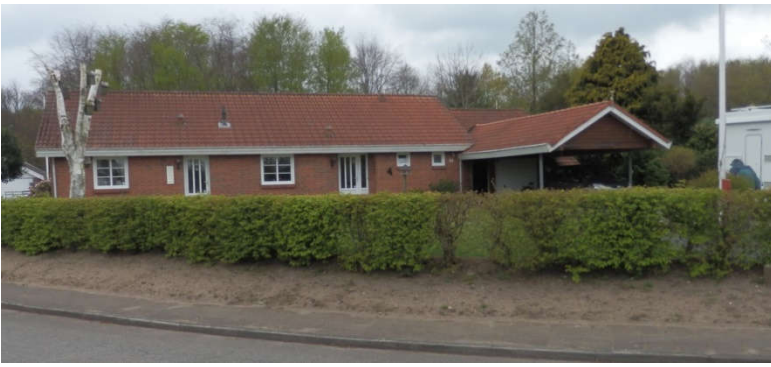
Lindevej 14 (Foto: April 2020)
