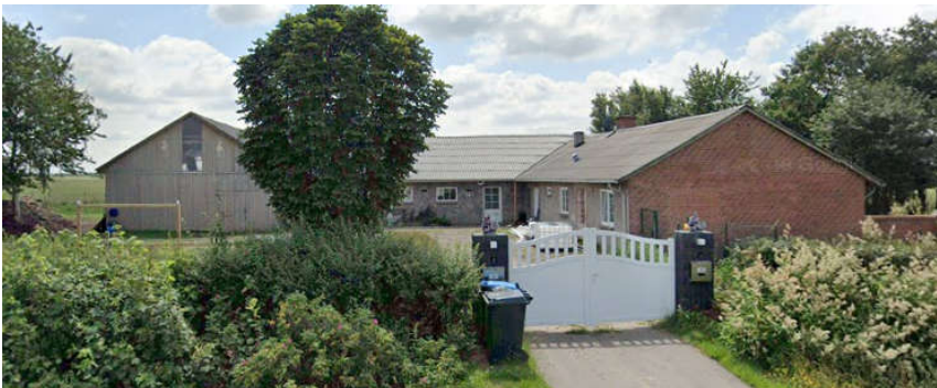
Ginegårdsvej 6 (Google Foto)
