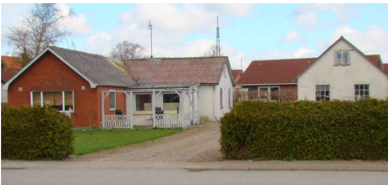
Lundbyesvej 23 (Foto: April 2010)
