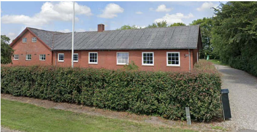
Ginegårdsvej 5 (Google Foto)
