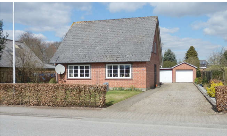
Lundbyesvej 5 (Foto: April 2017)
