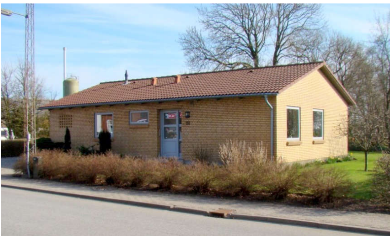
Lundbyesvej 28 (Foto: April 2010)
