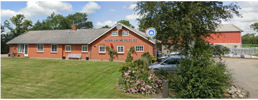
Ginegårdsvej 3 (Google Foto)
