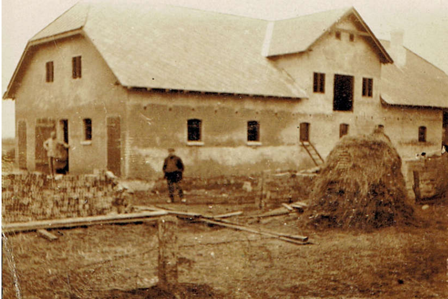
I 1919 brændte Hans Paulsen Enemarks gård (Bjergvej 4). Han genopbyggede herefter gården. Billede viser svinstalden, der blev opført i 1922, hvilket stadig fremgår af årstallet på kvisten. Hans Paulsen Enemark ses selv foran bygningen.
